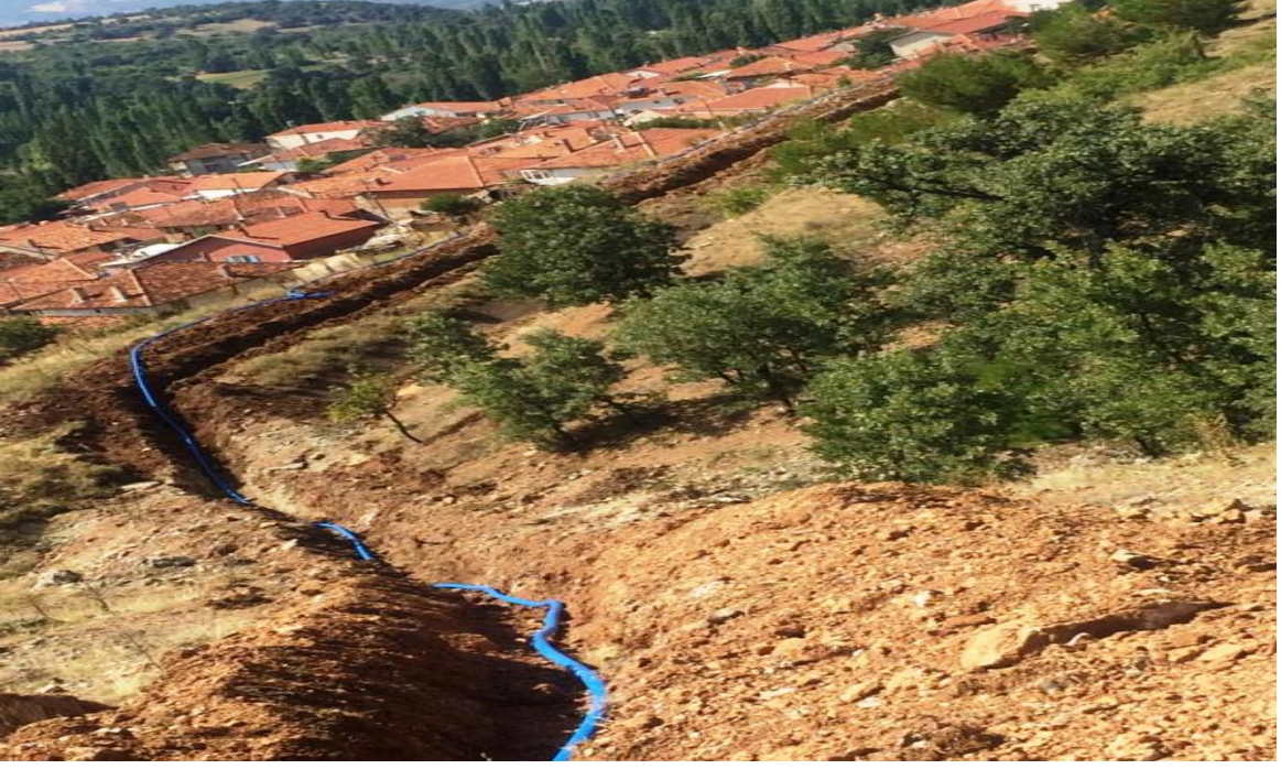
Gediz-Gürlek köyü içmesuyu isale hattı yapımı
