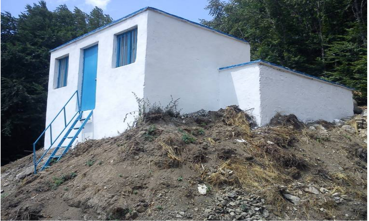
DOMANIÇ- YEŞİLKÖY 100 m 3 SU DEPOSU YAPIMI
