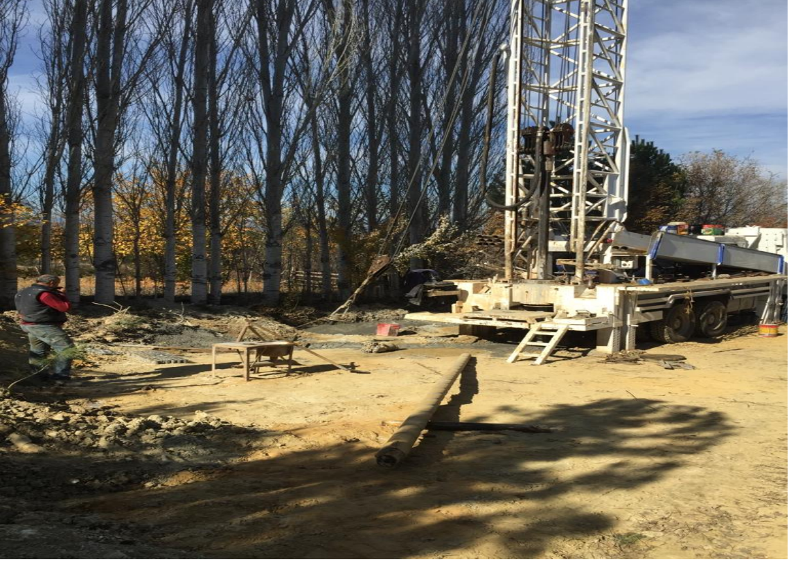
Hisarcık –Aşağıyoncağaç köyü içmesuyu sondaj çalışması
