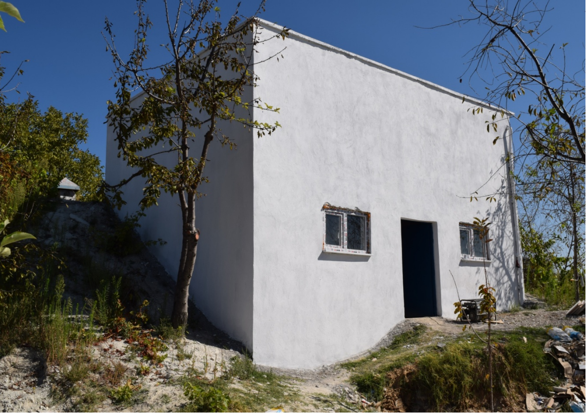
Pazarlar –Sofular köyü içmesuyu depo onarımı
