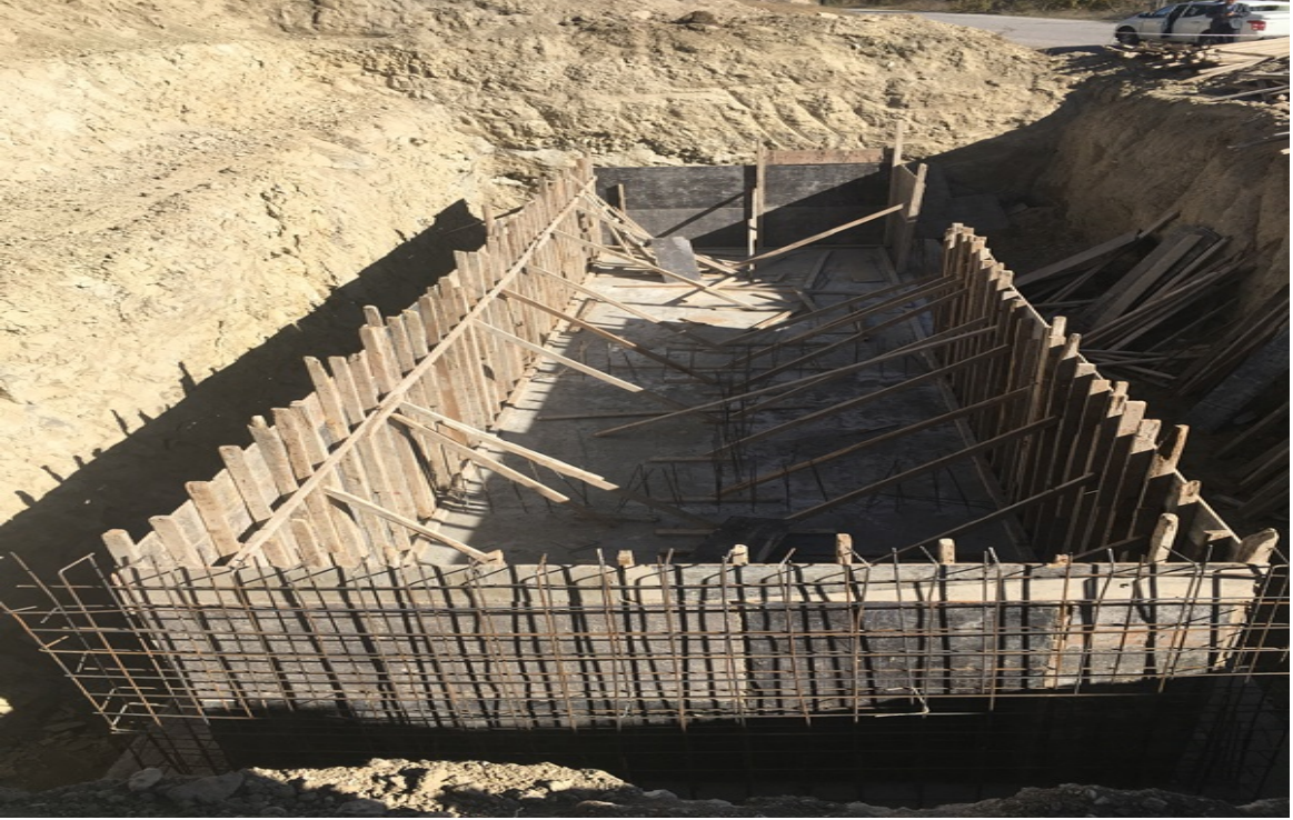
Gediz-Altinkent Köyü 1000'lik Fosseptik Yapım İşi
