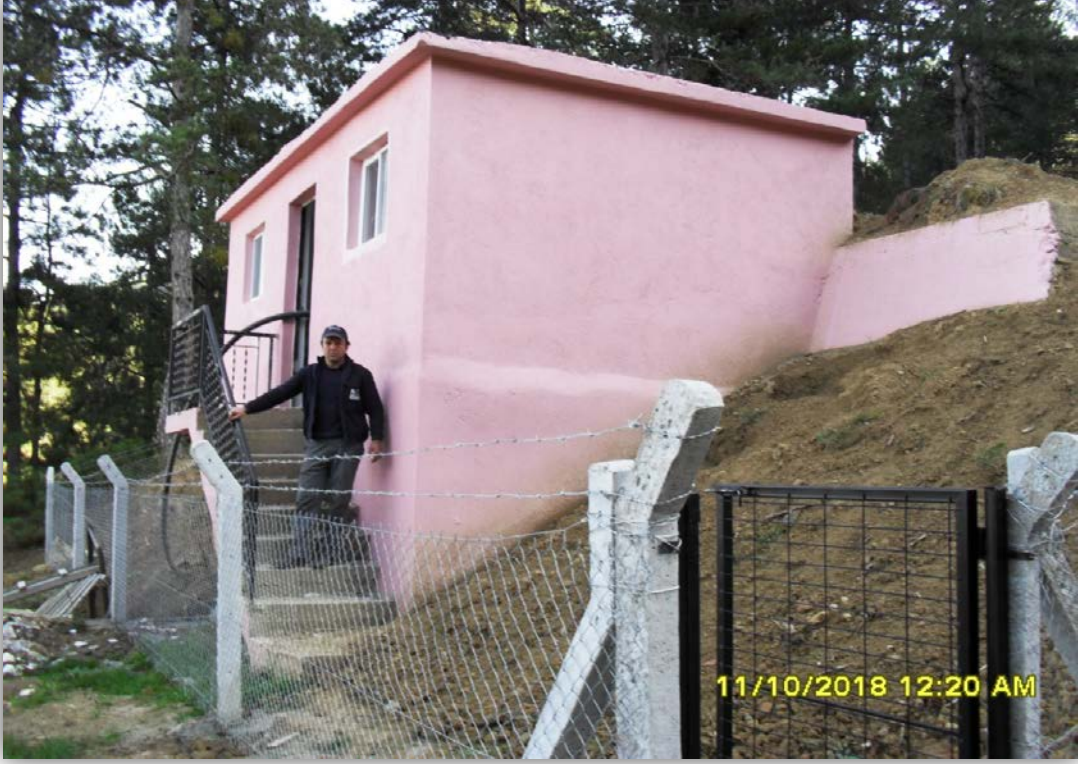
Simav-Aksaz köyü içmesuyu depo onarım işi
