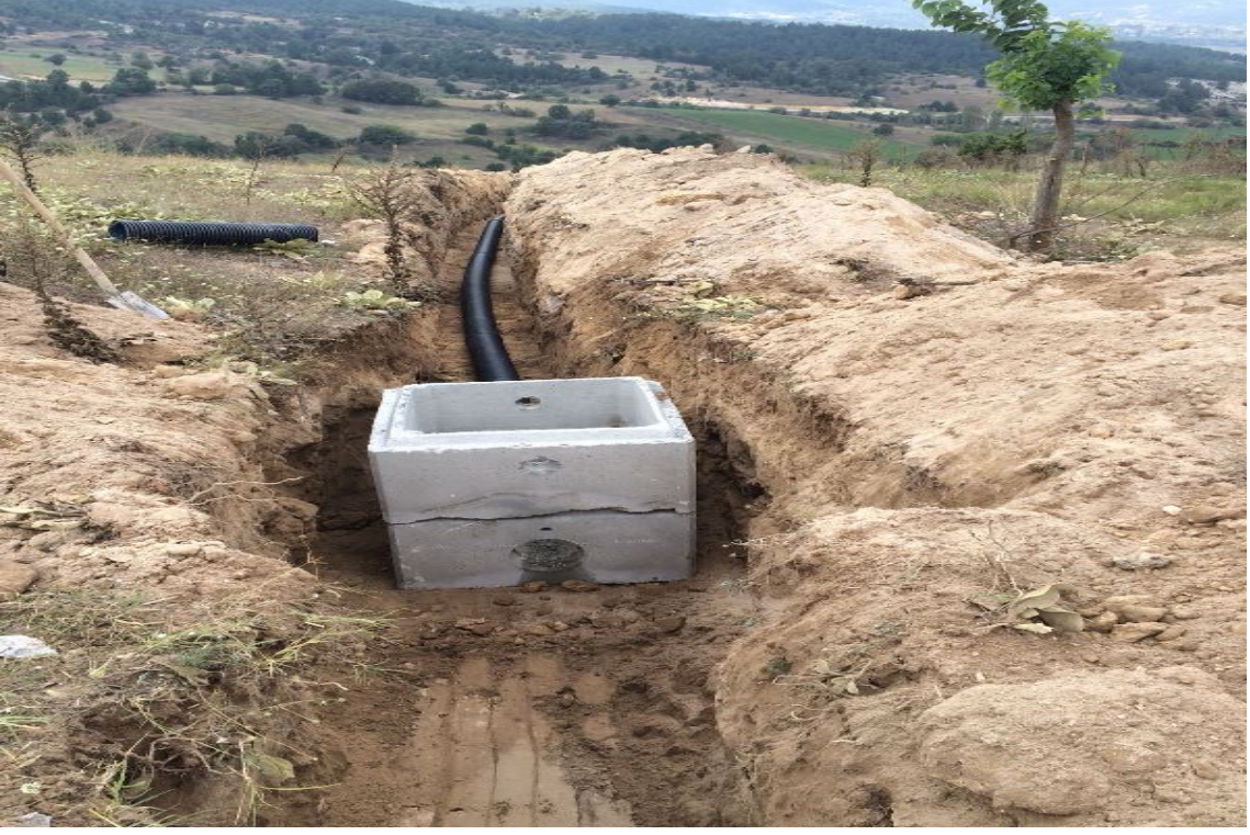
Gediz- Soğuksu Köyü Kanalizasyon Fosseptik Hattı Bağlantı Yapım işi
