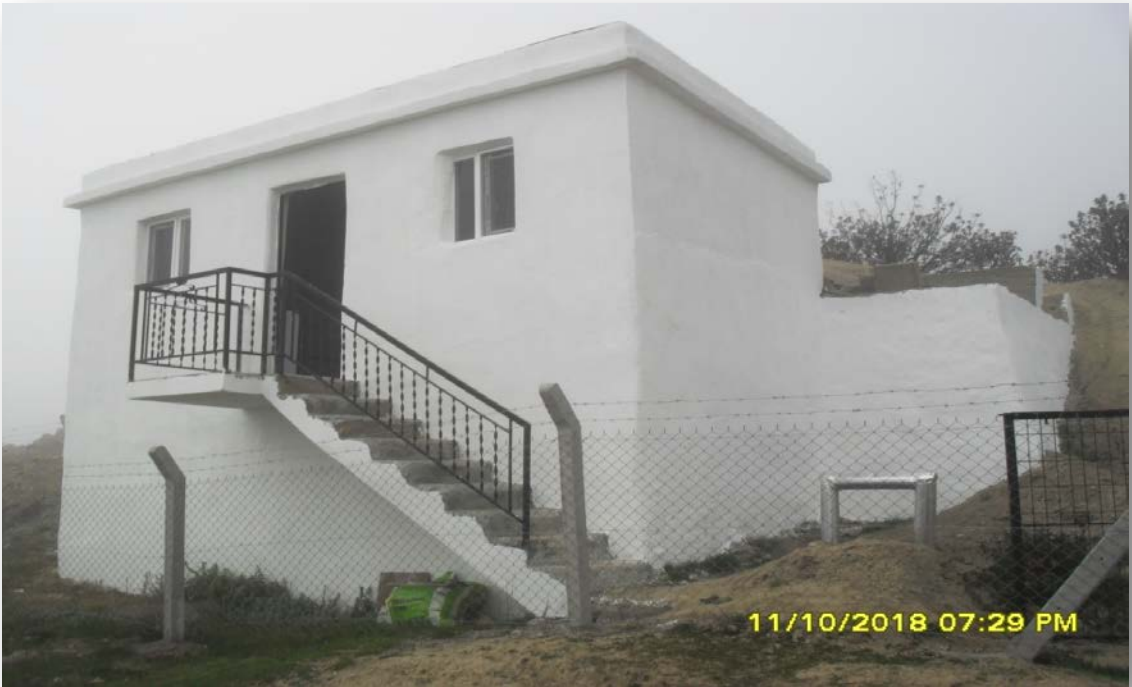
Simav-Çınarlidere köyü içmesuyu depo yapım işi
