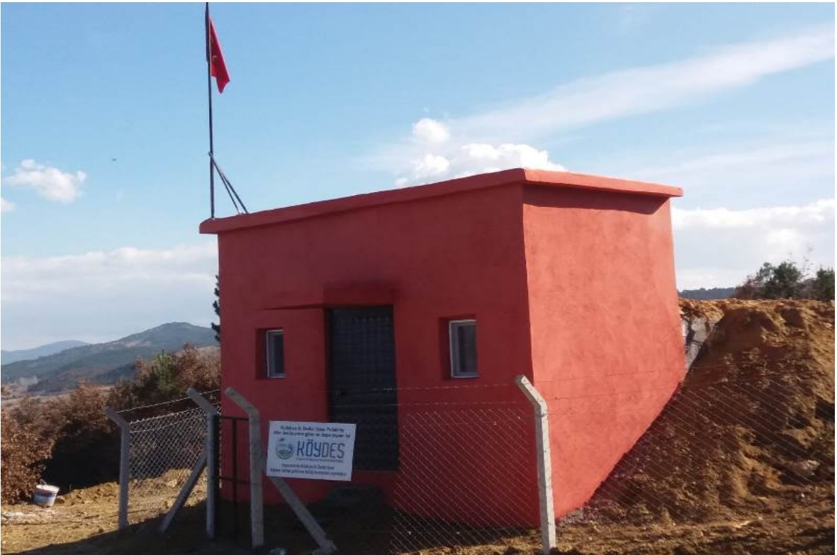
Gediz-Polat köyü içmesuyu depo yapımı
