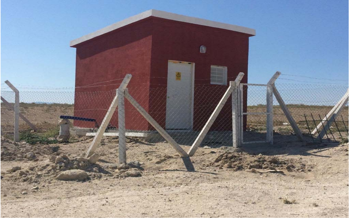
Aslanapa-Haydarlar Köyü Yeni İçme Suyu Tesisi (Terfi Hattı, Elektromotopomp, Otomasyon, Arıtma Binası ve E.N.H. Yapımı)
