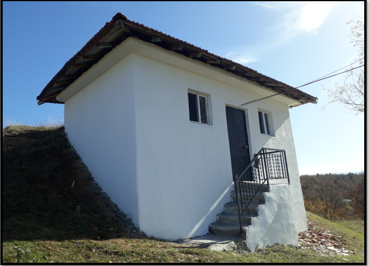
ÇAVDARHİSAR- YEŞİLDERE KÖYÜ 100 m 3 DEPO ONARIMI
