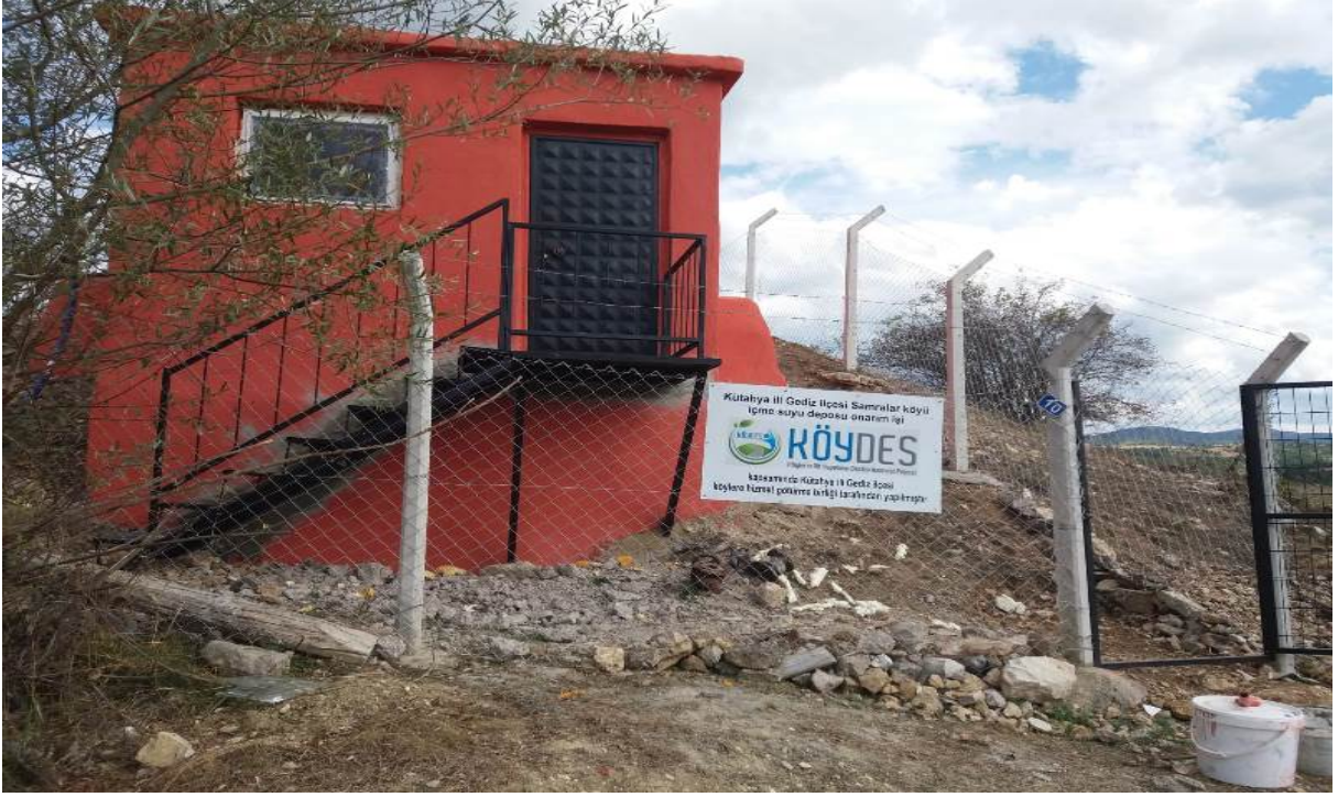
Gediz-Samralar köyü içmesuyu depo onarımı
