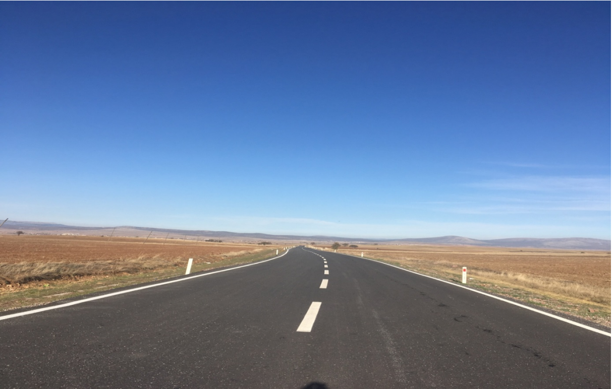
Aslanapa-Bezirgan, Ören, Tokul Grup Yolu 6,7 km BSK Asfalt Kaplama İşi
