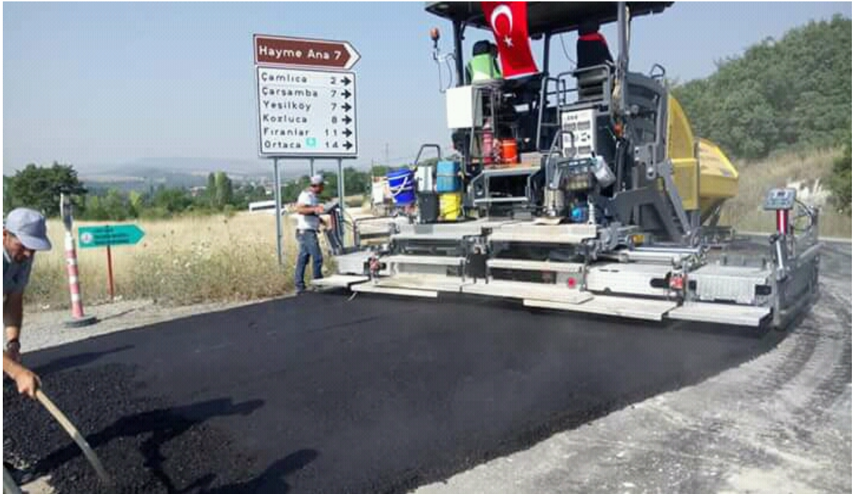
Dmaniç-İl Yolu-Çamlıca-Yeşilköy -Ortaca BSK Asfalt Yapımı
