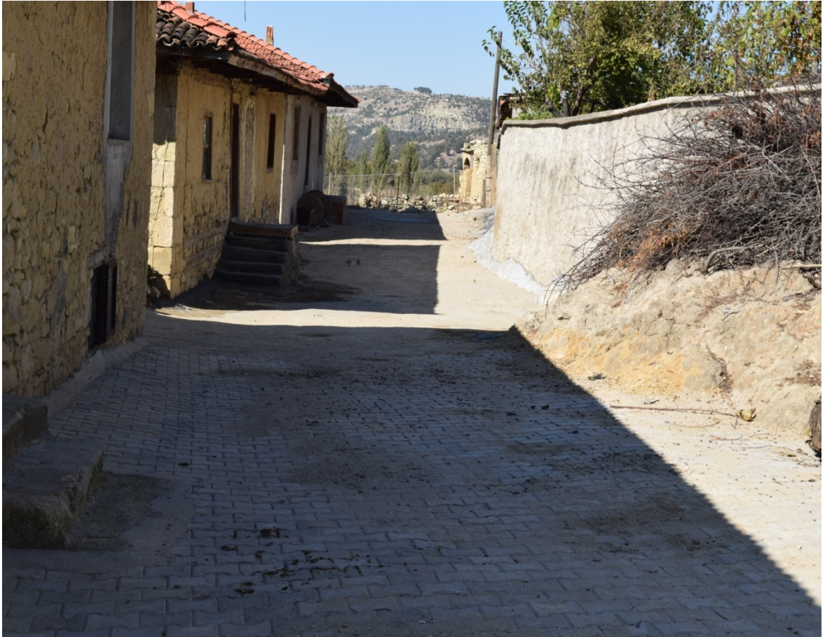
Pazarlar-Saray köyü kilitli parke taşı uygulaması
